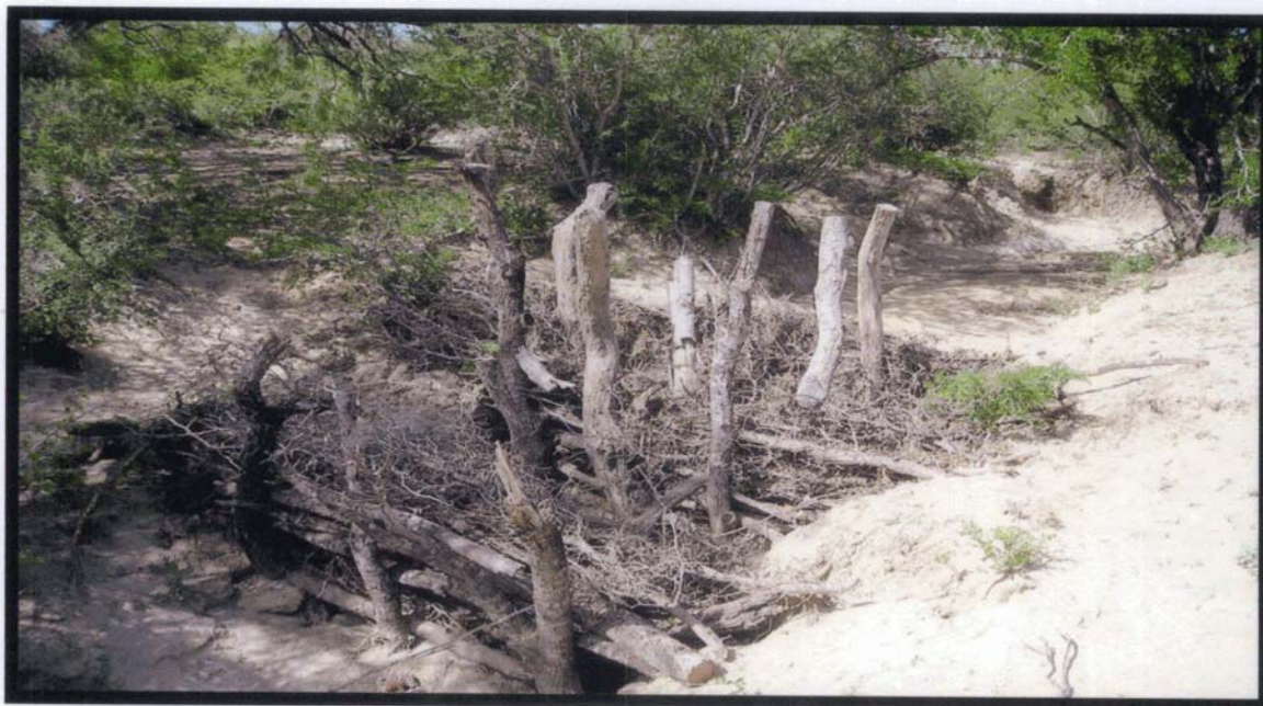
Foto No. 31.-Las represas filtrantes cumplieron con el objetivo de retener el suelo y propiciar la infiltración del agua
